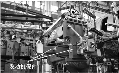
图 6 发动机假件的实物安装情况
